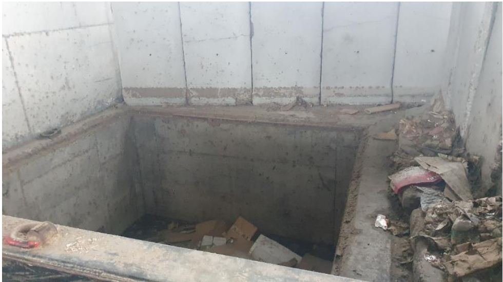
Figura 30. Vista de las instalaciones de la nave de Tratamiento II. Detalle del foso a hormigonar en la situación reformada.
